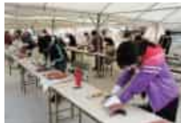
▲再建で再利用される赤瓦のしっくいをはがすボランティアの様子。
