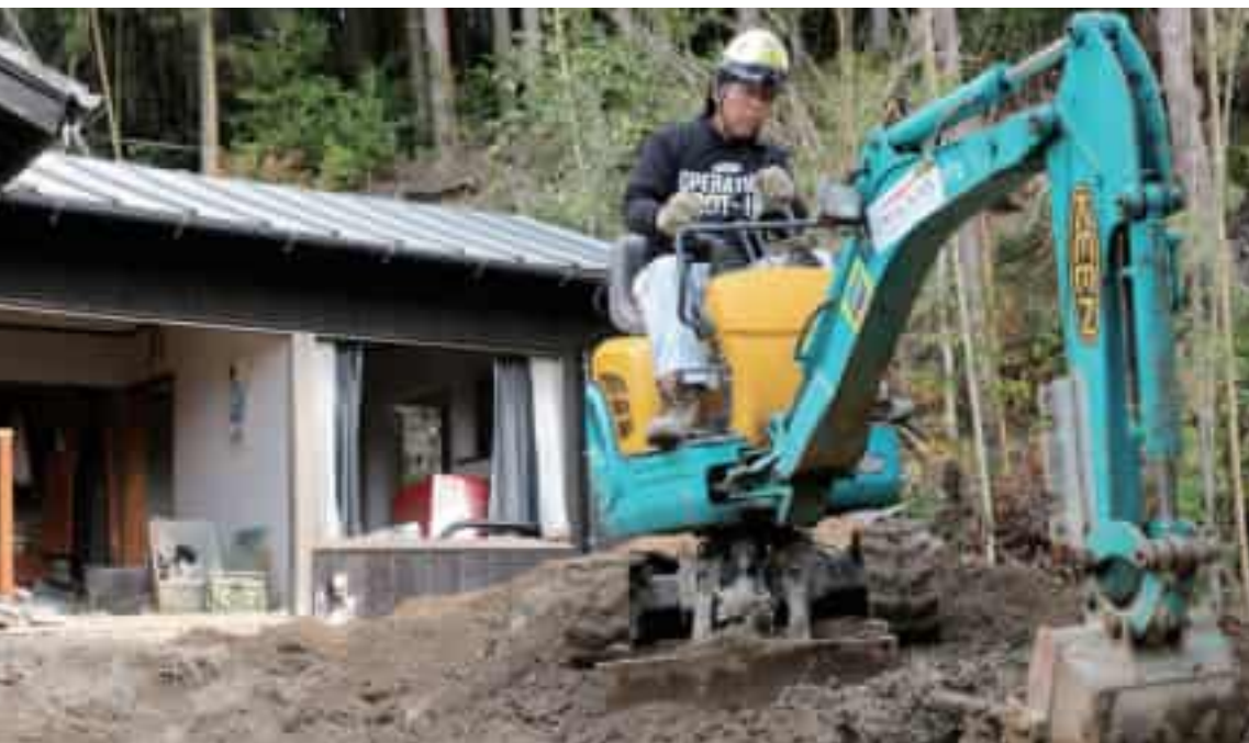
土砂くずれの現場では、各地からかけつけたボランティアが重機を使って、住宅におしよせた土砂をとりのぞきます。
